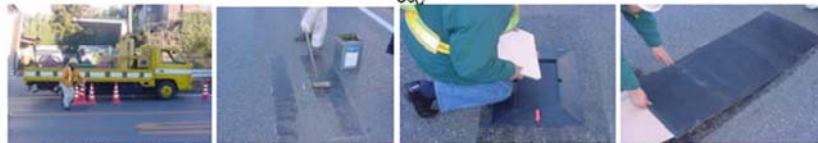
道路誘導員により車線規制 ⇒ 接着用シール剤の塗布 ⇒ 台座の貼り付け・計測機器の設置 ⇒ 専用保護シートの貼り付け
